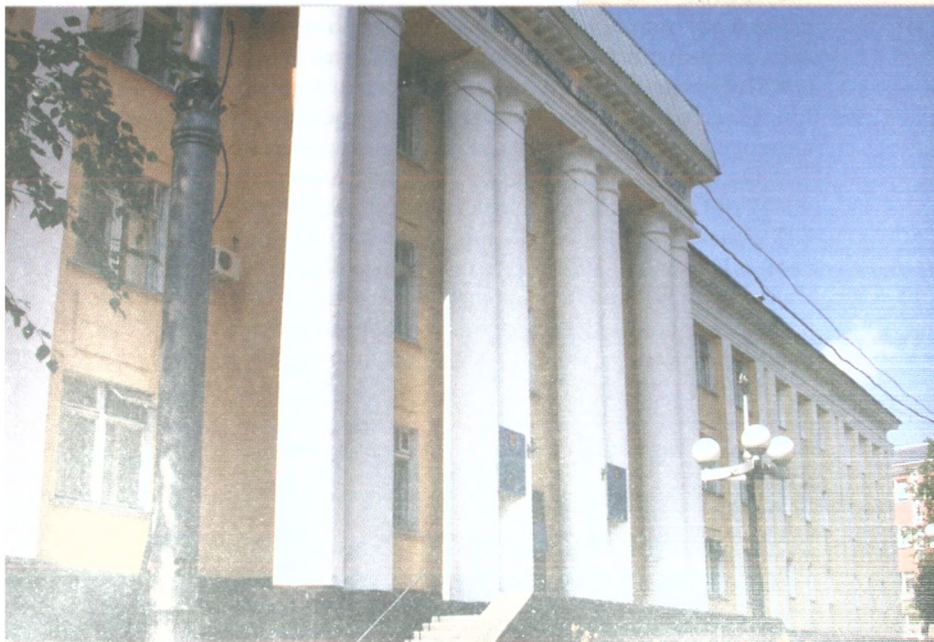
Здание МВД по Республике Коми. Современное фото
