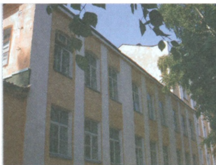
Бывший дом Суворовых (перестроен). Современное фото
