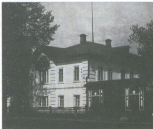
Братский корпус подворья Ульяновского монастыря. Фото 1940-х гг. Из фондов ГУ РК НА РК
