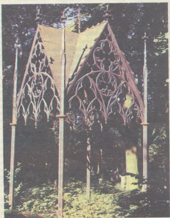
Чугунный балдахин над фамильным склепом семьи Верманисов. Его стоимость по оценке комиссии Министерства культуры 17 тыс. руб. Уничтожен при благоустройстве
