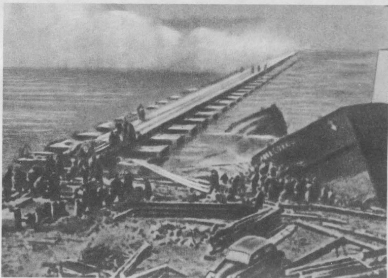
Возводится мост через Одер
