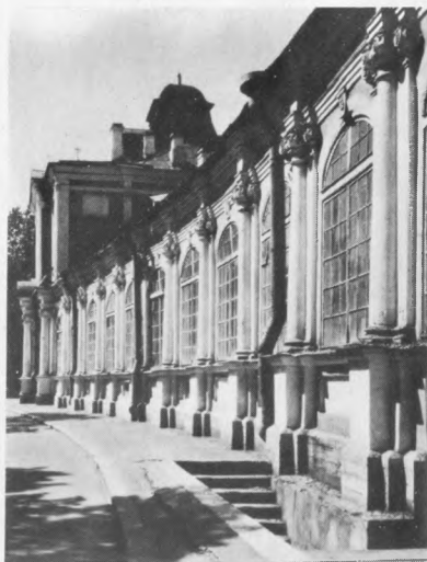
Санкт-Петербург. Александро-Невская лавра. Троицкий собор
