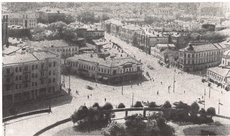
Дом между Пречистенкой и Остоженкой, 1930-е гг. (ул. Пречистенка, 1, ул. Остоженка, 2)
