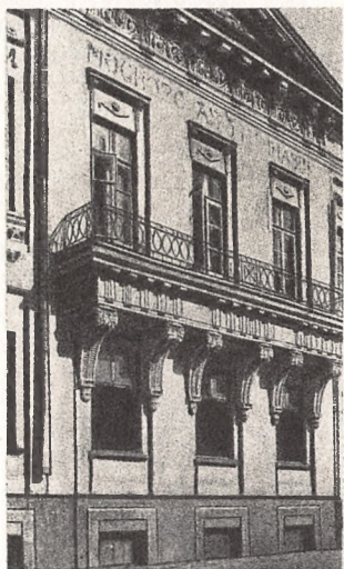
Дом князей Голицыных, начало XX в. (ул. Б. Лубянка, 12)
