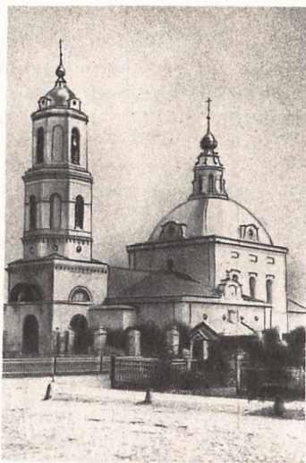
Церковь святого Николая чудотворца в Кобыльском, 1880-е гг. (ул. Земляной вал, 21)
