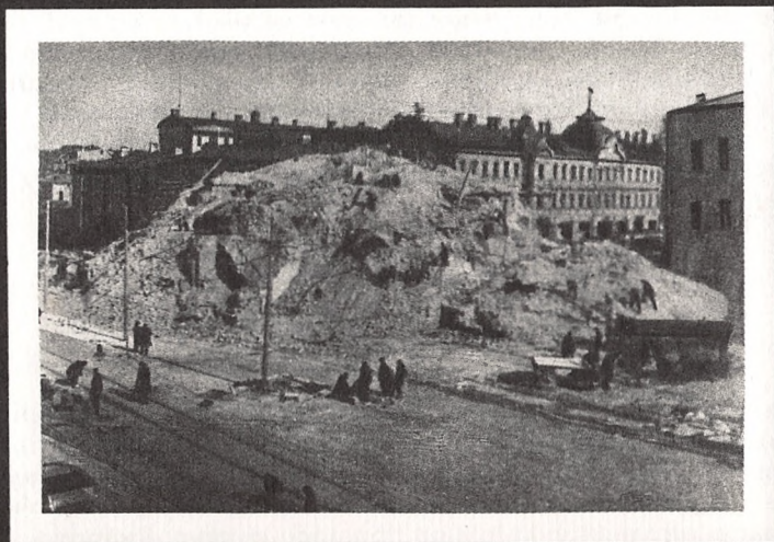
Разрушение Суарева башни, 1934 г.
