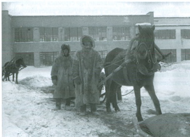
Местные жители на стройке. Начало 1930-х гг.
