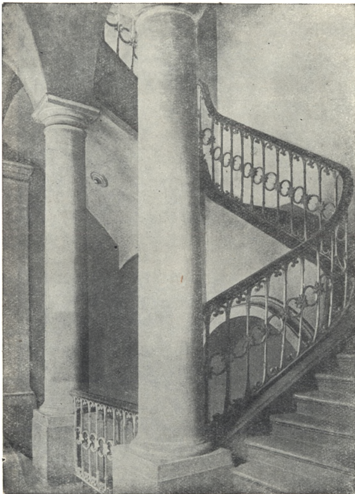
Парадная лестница (площадка второго этажа, в прежнем состоянии).
