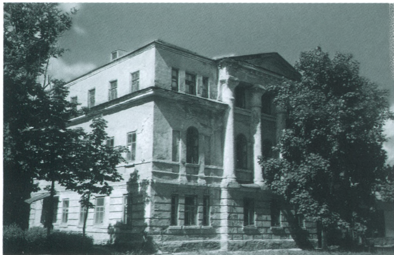
Фатеж. Дом (до реставрации), в котором родился композитор. 1966 г. Фото публикуется впервые.
