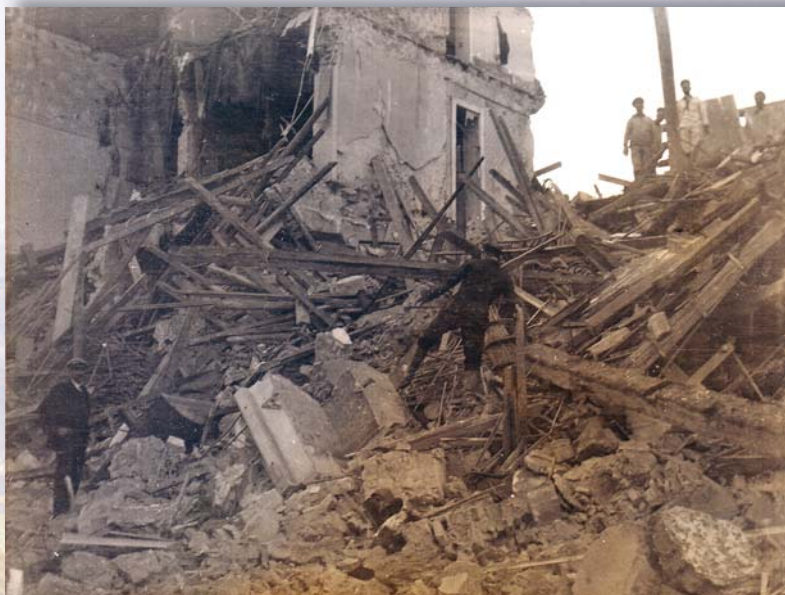
Работы на Виа Гарibaldi
