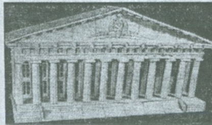
● Фасад Горного института.
