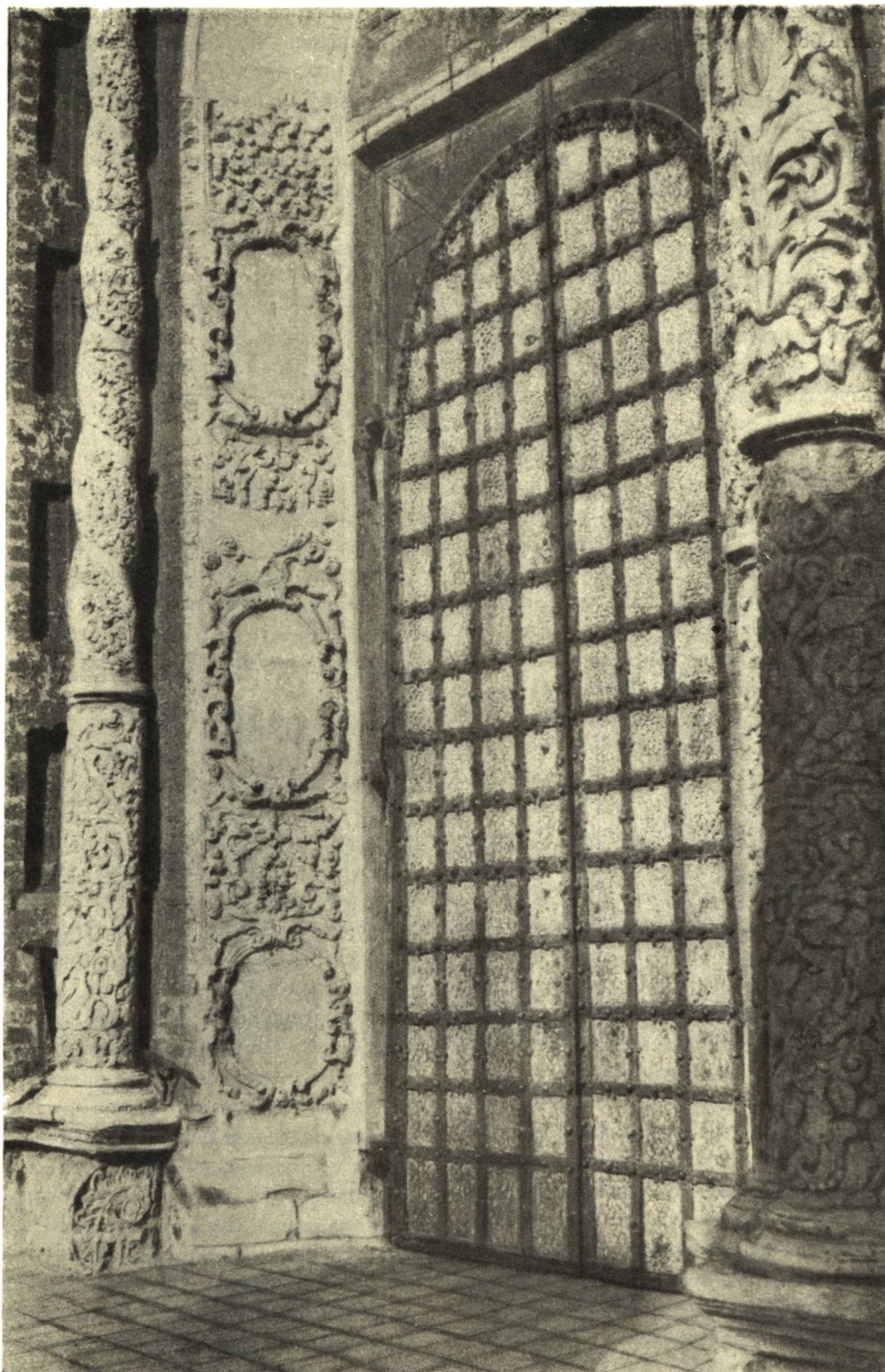
Рис. 30. Успенский собор в Рязани. Дверные полотна южного входа
