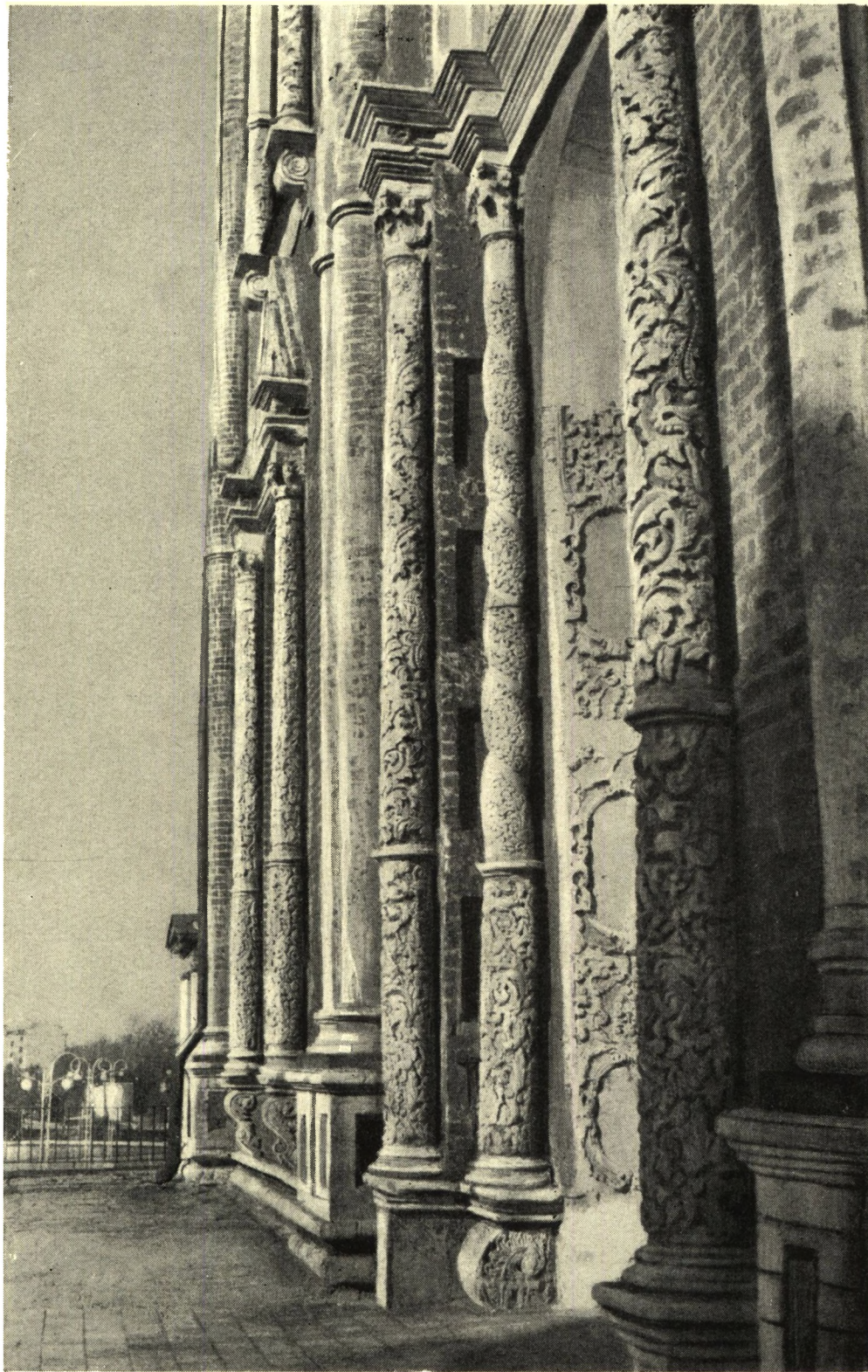
Успенский собор в Рязани. Фрагмент южного фасада
