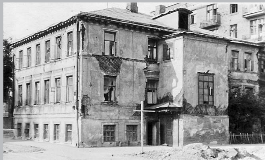
1958 год. Дом на Землячке (вход на первый и второй этажи – справа, в конце заборчика, где и сделана фотография с сёстрами Бесфамильными; вход в полуподвал – слева, под козырьком: там жила и семья Жильцовых, чья дочь Света стала диктором ТВ), пятиэтажка на дальнем плане была построена незадолго до расселения...
