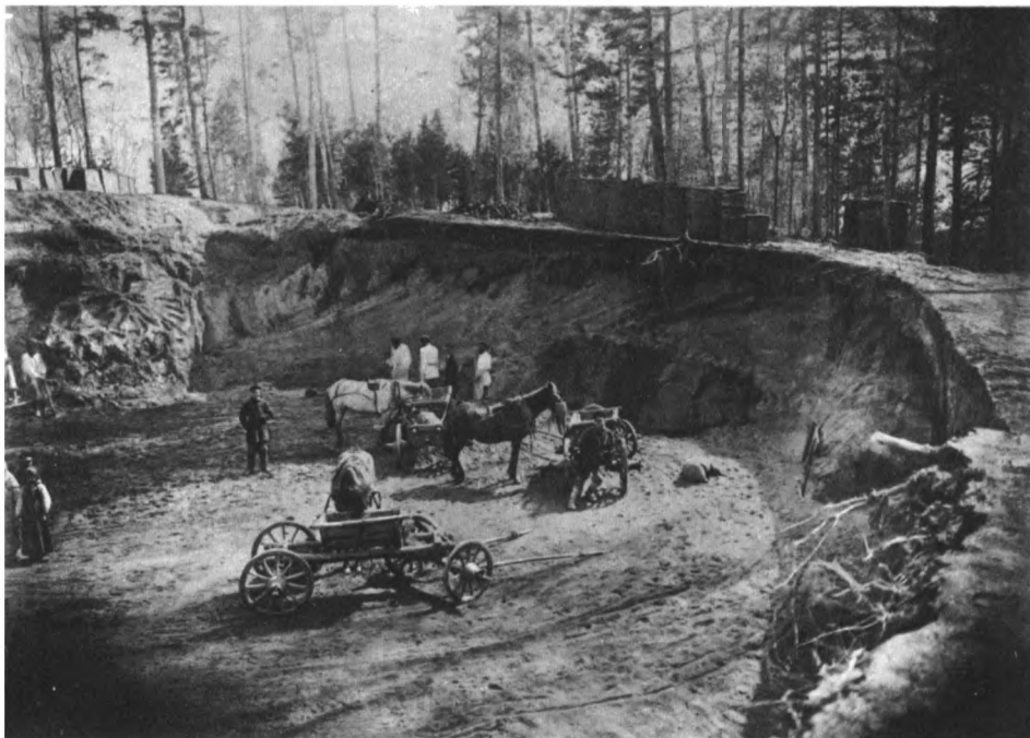
Котлован под церковью во Флёнове
