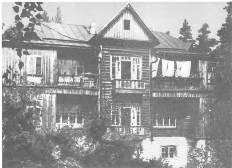
Лабораторный корпус в Миассово. Вид со стороны озера. Наверху в центре раскрыта балконная дверь кабинета Н.В.Тимофеева-Ресовского
