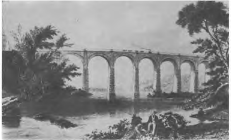
Виадук на вашингтонском участке железной дороги Балтимор - Огайо, 1836 г.
