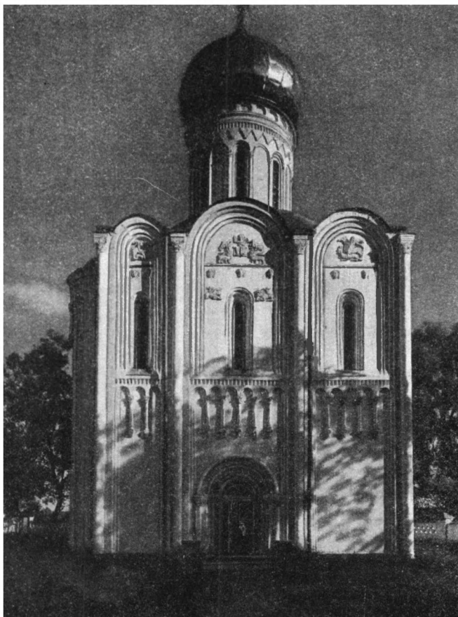
82. Церковь Покрова на Нерли. Северный фасад
