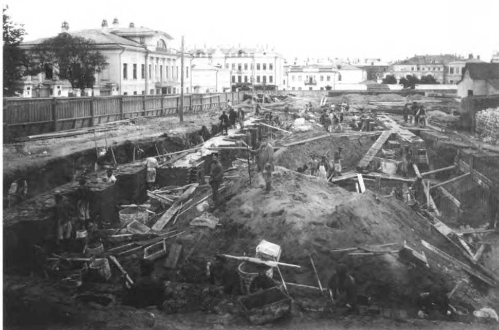
131. Кладка фундамента Музея. В центре – И.И.Рерберг. 1899 г.
