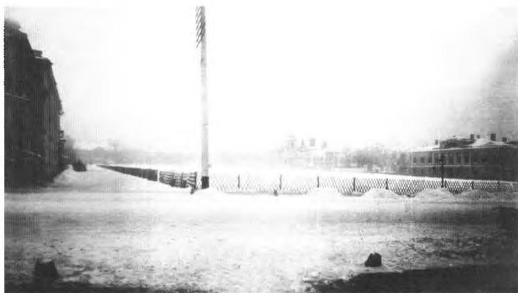
116. Территория Кольмажного двора. 1897 г.
