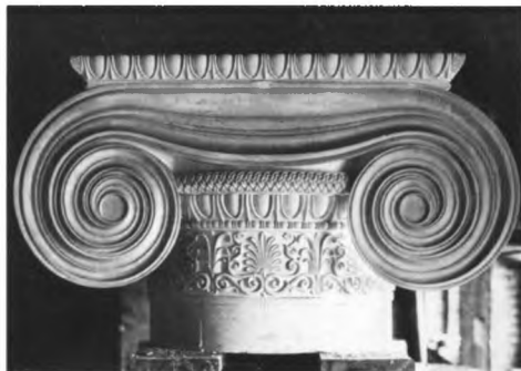
95. Гипсовый шаблон ионической капители для колонн внешней колоннады Музея изящных искусств.. Создан по образцу капителей Эрехтейона. 1901–1902 гг.
