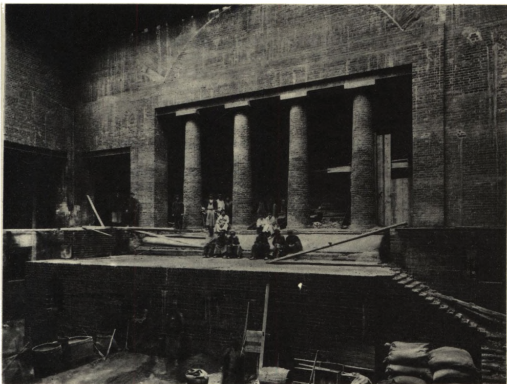
80. Греческий дворик во время строительства
