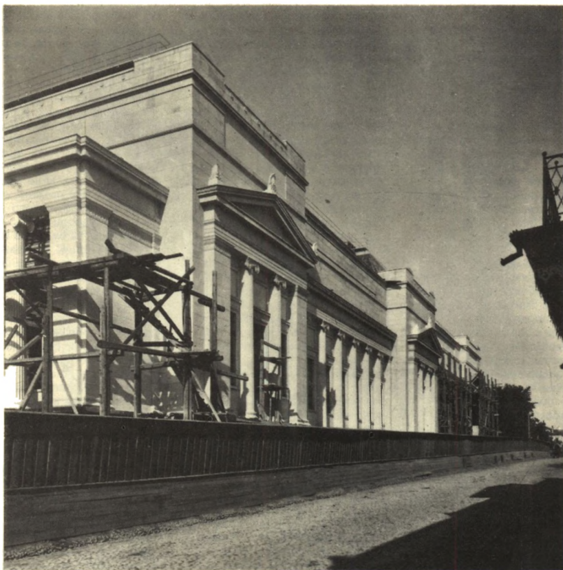
90. Последние леса на боковом фасаде Музея
