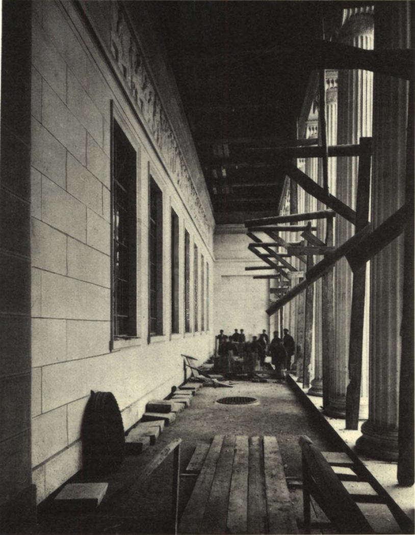
92. Главный портик Музея во время строительства
