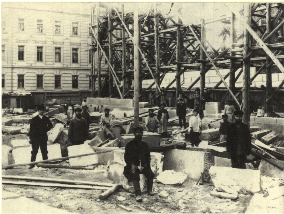
66. Владимирские рабочие на стройке Музея
