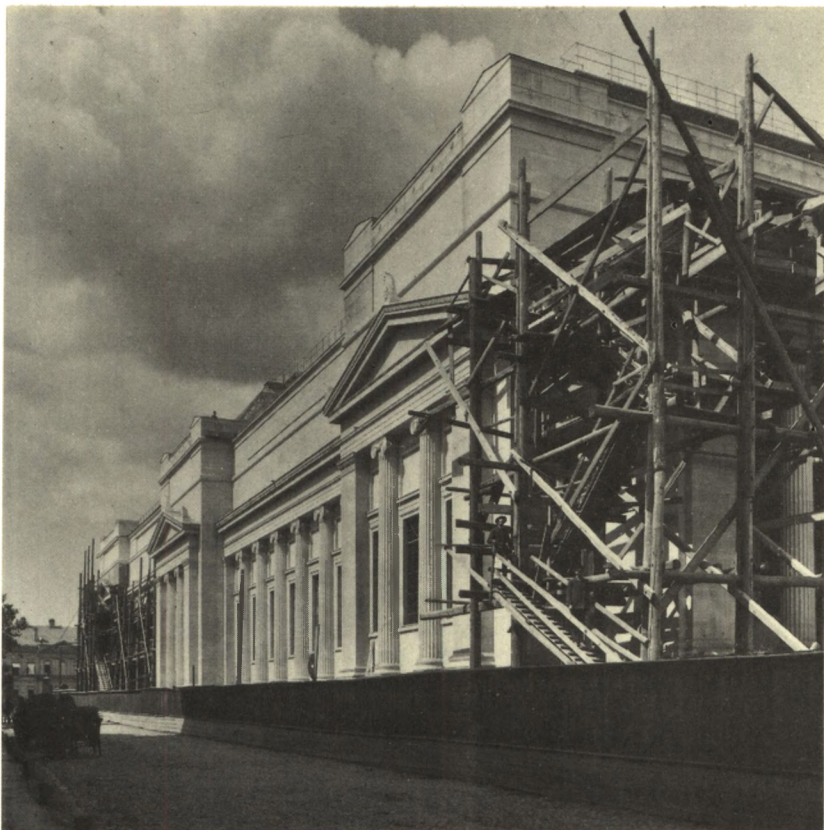
91. Последние леса на боковом фасаде Музея
