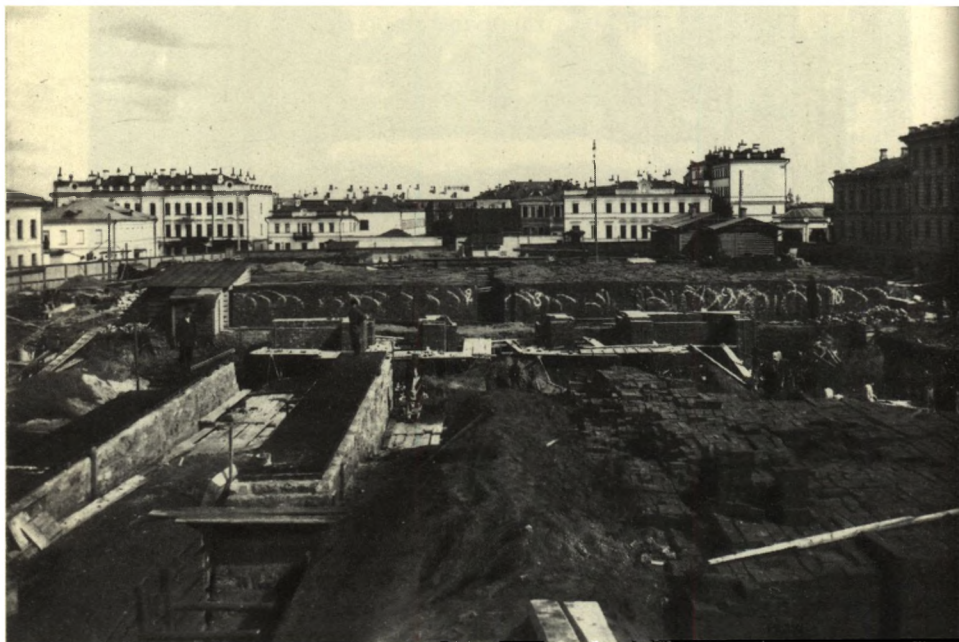
54. Закладка фундамента Музея
