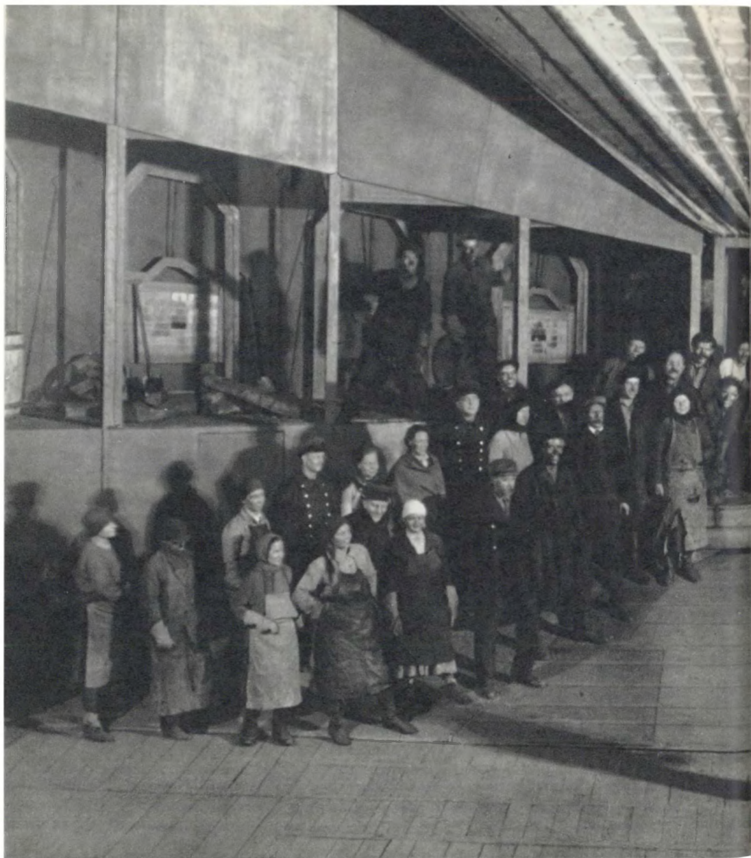
«Поэма о топоре». Нержавеющая сталь сварена!
