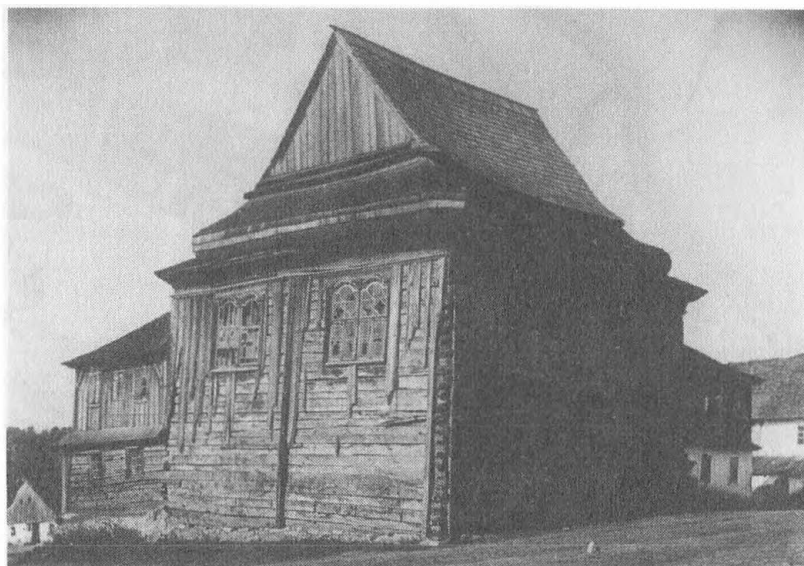
Рис. 10. Деревянная синагога в Лянцкоруни, вид с северо-востока (фото начала XX в.).
