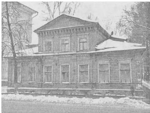
Дом А. А. Ключковой. 1837 год, архитектор Г. И. Кизеветтер
