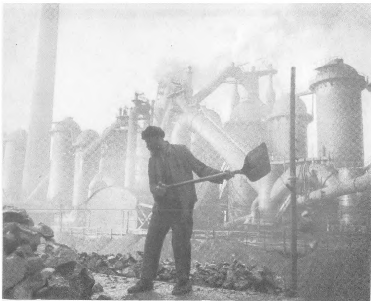
Строительство Магнитки. 1929 г. Фото Д. Дебабова.
