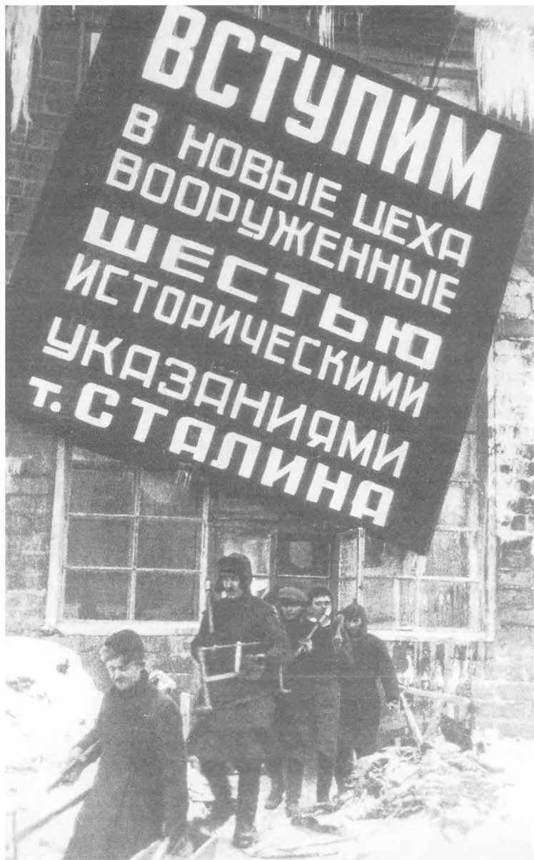
На строительстве Магнитки. 1929 г.
