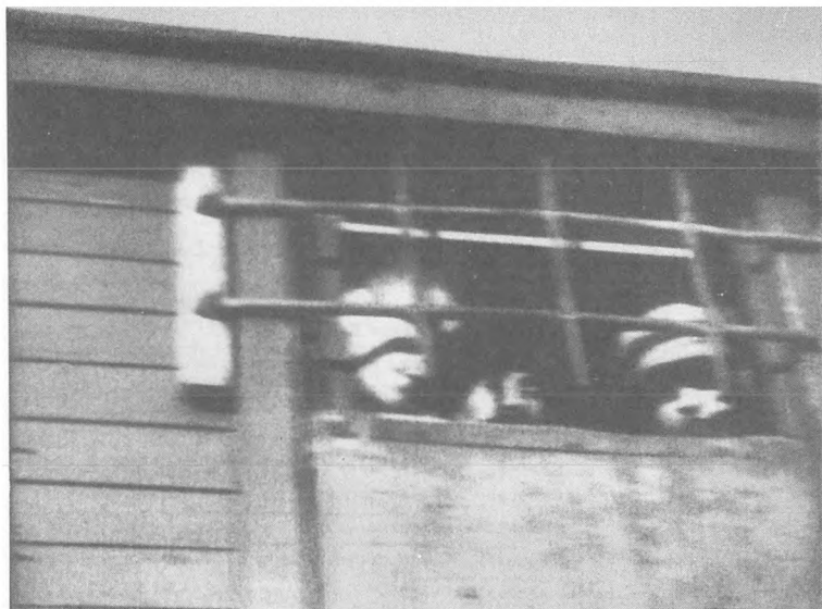
На строительство канала Москва — Волга (кадр из фильма).
