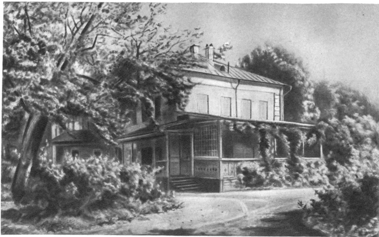
Вид со стороны подъезда. На переднем плане «дерево бедных».
