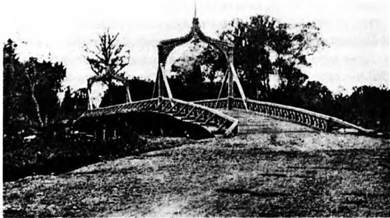
Мост через Тымь в Рыковском
