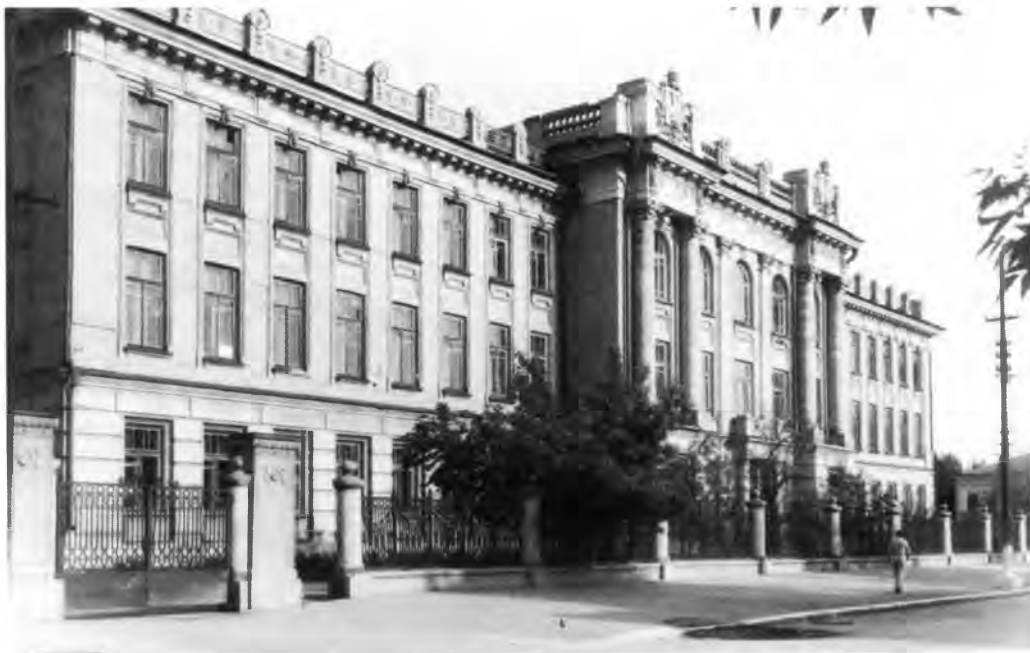
Здание Физического института Саратовского университета. Вид с улицы Университетской (бывшей Казарменной). Фото 1950-х годов.
