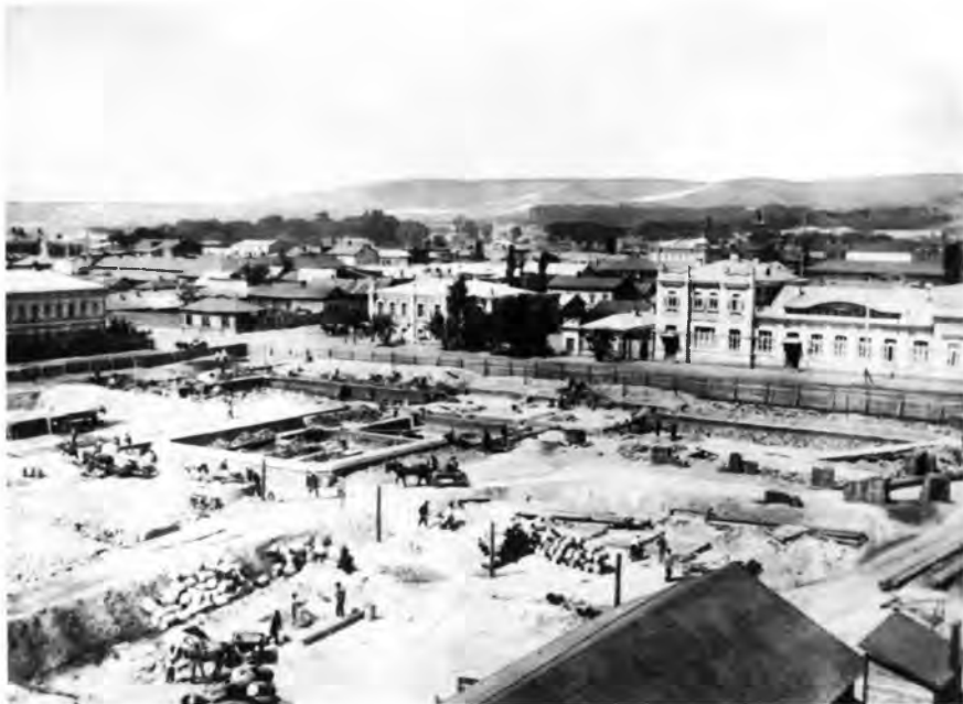
Закладка фундамента при строительстве Физического института. Саратов. 1911 год.
