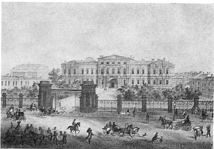
В. Ф. Тимм. Меншиковский дворец. Первый кадетский корпус А. Н. Авнатомов, Н. Брезе. Литография с рисунка И. И. Шарлеманя. Здание Пажеского корпуса. 1859
